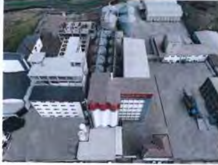
Tekirdağ/Çorlu Tesisi bünyesinde inşaatı süren yeni üretim tesisi
